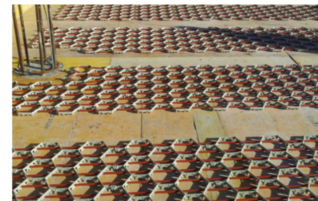
Födémzsaluzatra fektetett Wavin CW-90 regiszter panelek
