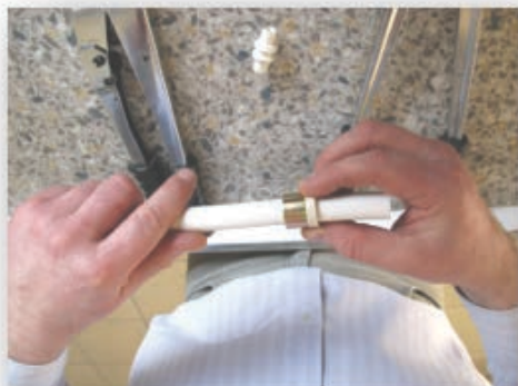
3. Cső idomra történő rátolása kézzel
