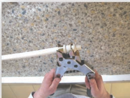
4. Toldóhüvely idomra történő ráhúzása, kötés véglegesítése
